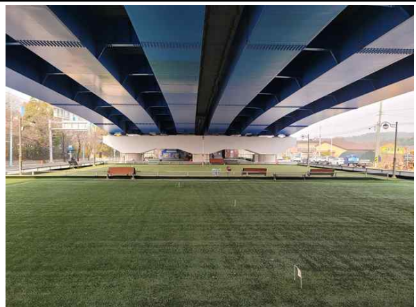
교각 P7 기초 전경
