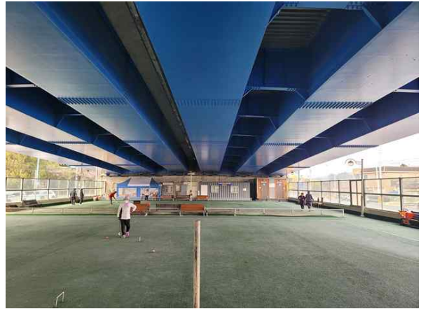
교대 A2 기초 전경
