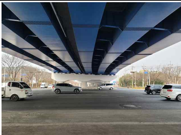
교각 P4 기초 전경
