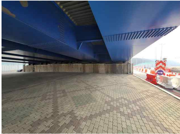
교대 A1 기초 전경
